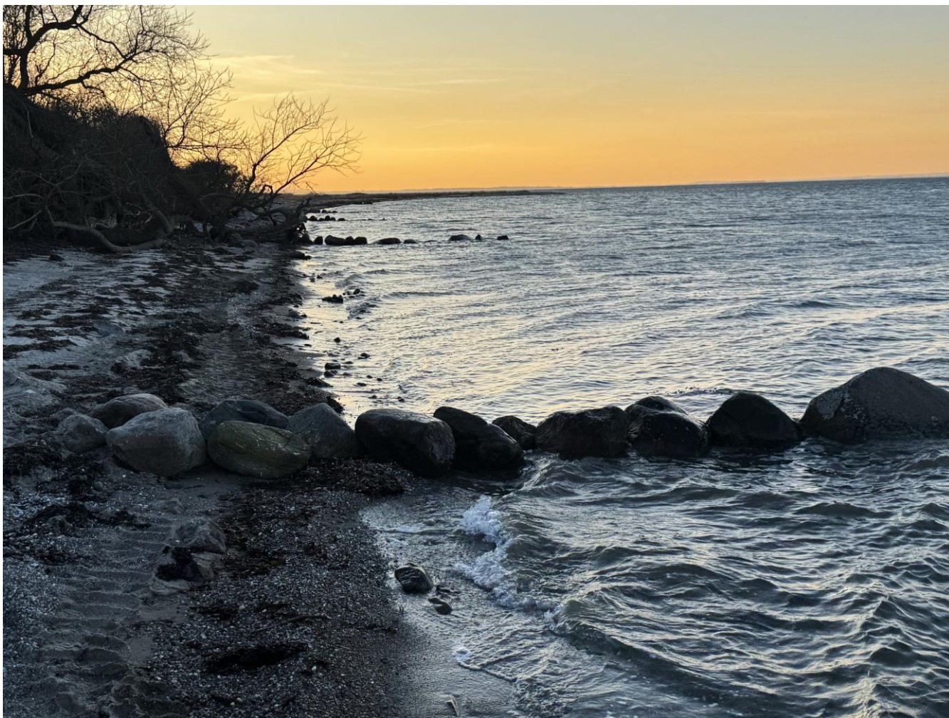
6-7 nyetablerede høfder med brug af strandstenene
