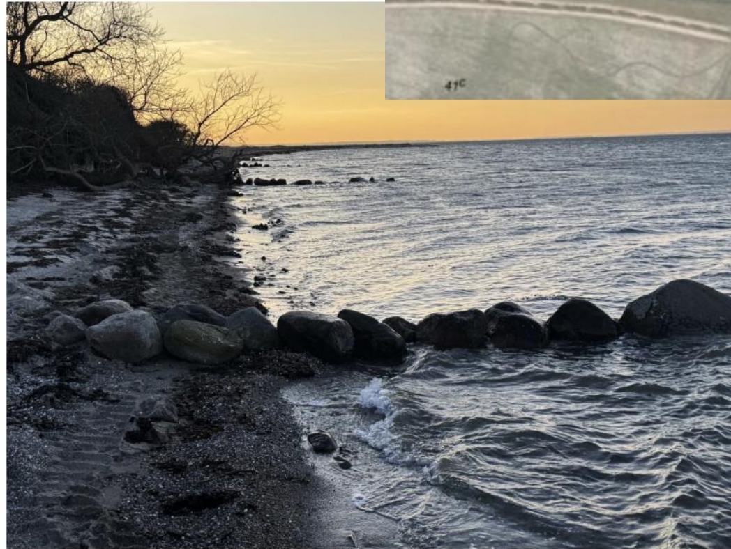
6-7 nyetablerede høfder med brug af strandstenene
