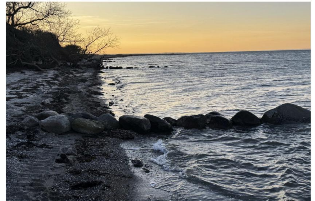
6-7 nyetablerede høfder med brug af strandstenene
