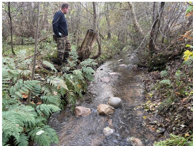
Udlægning af større sten i gydebæk 2025. Skaber skjul og giver et mere varieret flow hvor gydegrus skylles rent. Foto Jesper Knudsen.
